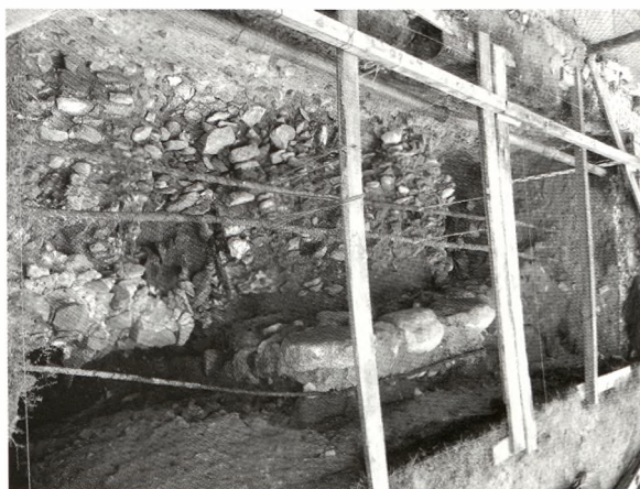
Ryc. 8. Poznań – Ostrów Tumski. Przewrócona ściana kaplicy z zarysem okna (zdj. Andrzej Sikorski)
